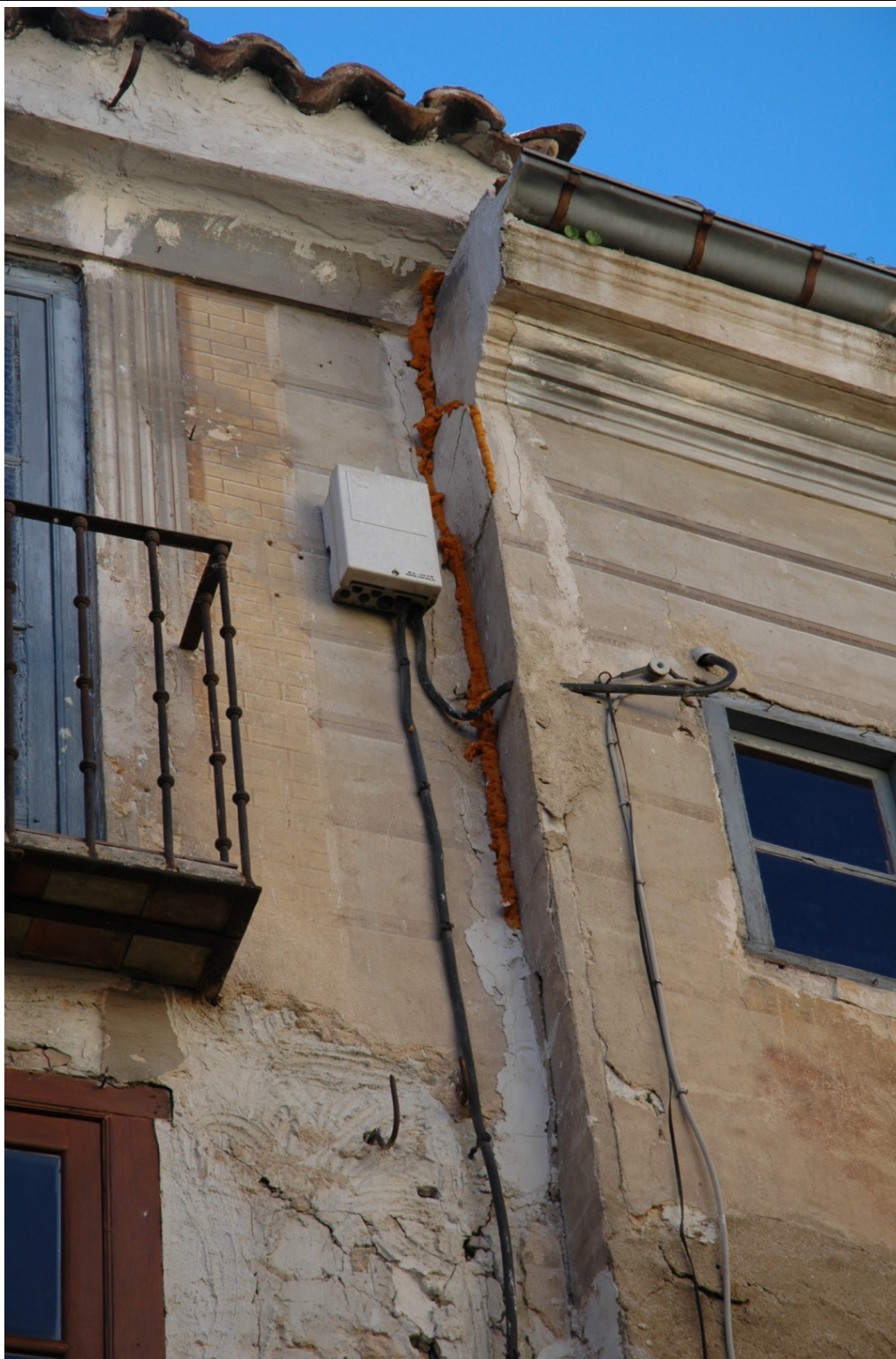
Detalle de la grieta formada en la fachada Noreste de la Calle Aljibillos, por el desplazamiento del bloque de Travesía de Aljibillos con respecto al bloque de la Calle Aljibillos. Este detalle corresponde a la junta de unión de las dos casa originales que forman la unidad actual.
