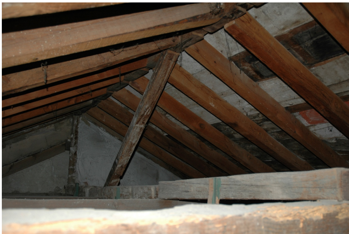
Imagen de la estructura de la cubierta.
