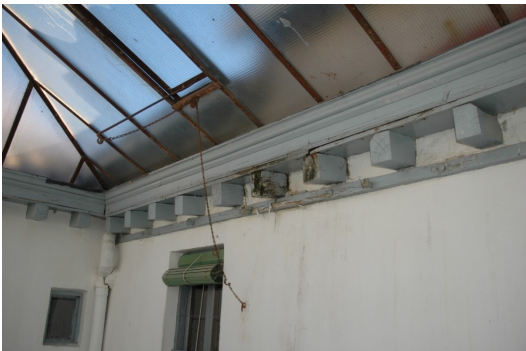
Imagen del encuentro del lucernario del patio con las fachadas interiores. Se aprecian daños en las cabezas de los pares, producidos por las filtraciones desde el canalón. De igual forma se aprecia que la estructura del lucernario se encuentra totalmente oxidada.
