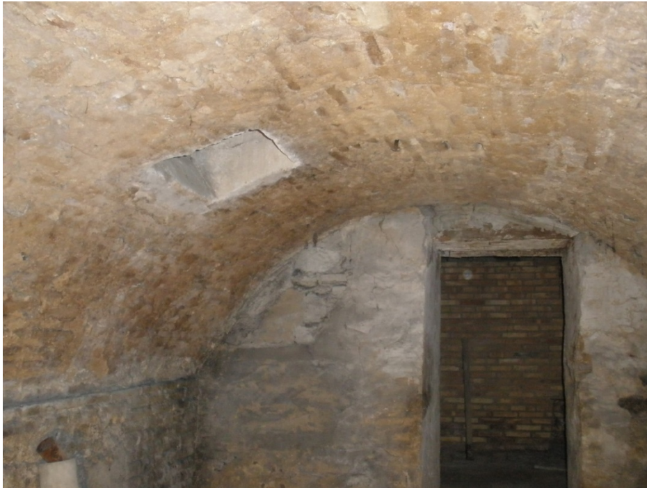
Sótano. Galería Noroeste. Muros de cimentación de fábrica de piedra irregular y bóvedas de ladrillo.
