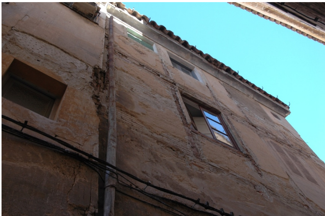
Muro de carga de fachada. Se observan grietas y pérdida de recubrimiento de los entramados de madera.
