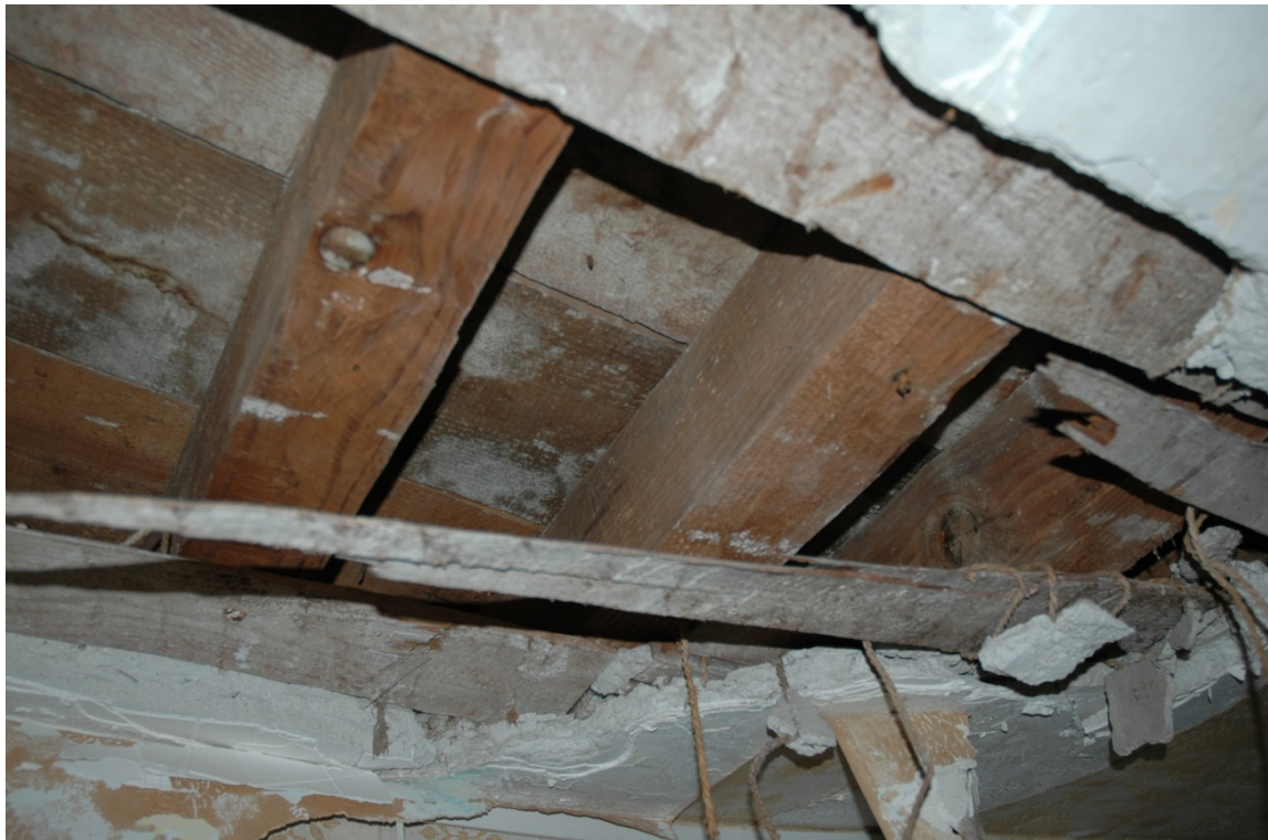
Imagen de los forjados de madera.
