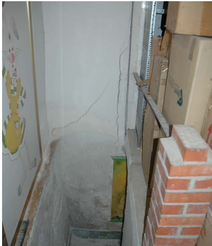
Imagen de muro de carga interior. Se observan grietas.
