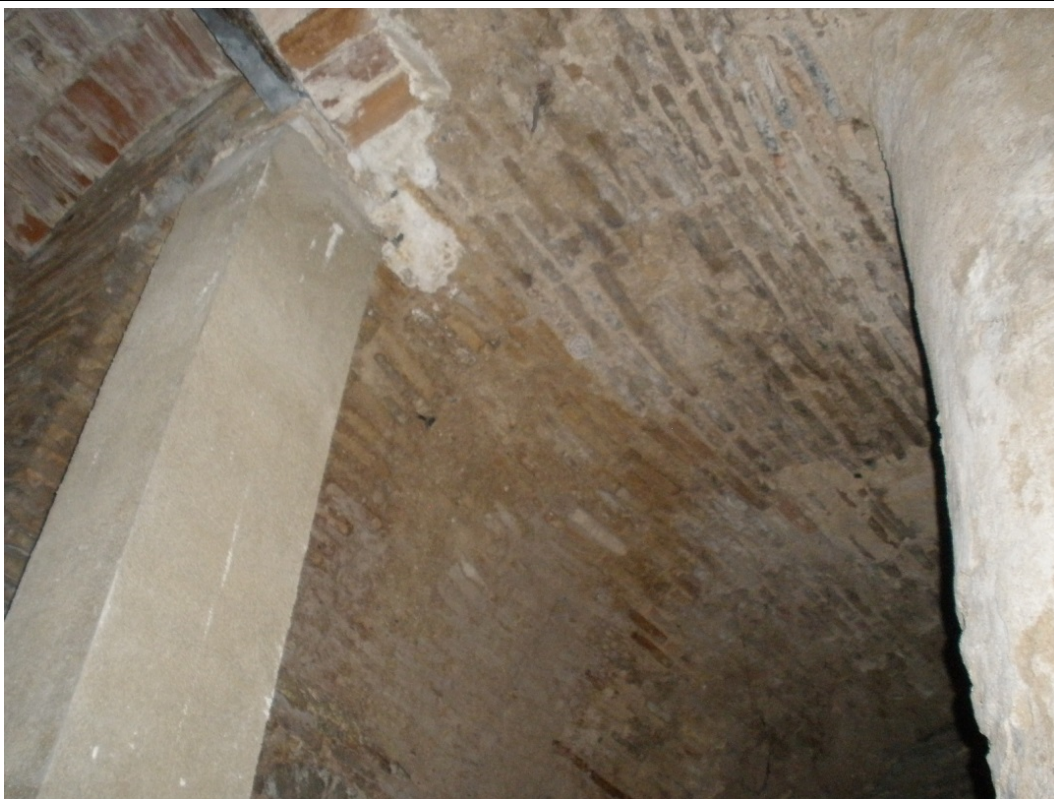
Sótano. Detalle del techo de la sala anterior en el que se ve a la derecha el cuello de un aljibe, y a la izquierda una rotura de la bóveda del techo para una antigua escalera.
