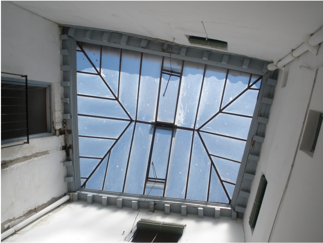
Imagen del encuentro del lucernario del patio. Presenta multitud de filtraciones desde la propia carpintería y a través del canalón perimetral.
