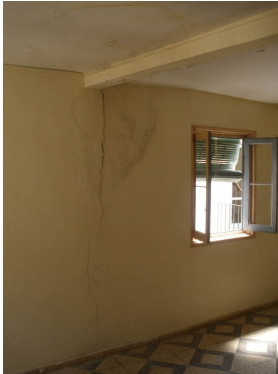
Interior de planta segunda de vivienda de Calle Aljibillos, 3. Se observan grietas en los muros del patio y grandes zonas de humedades en paramentos y techos.
