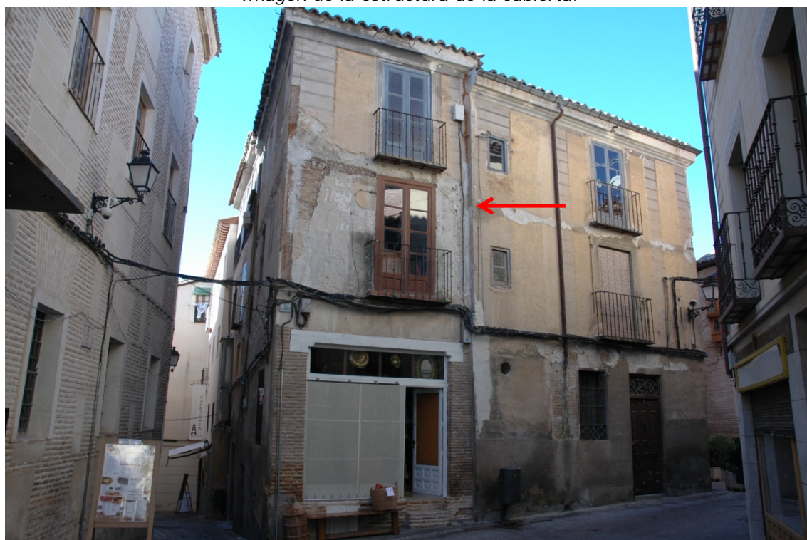
Imagen general de la fachada Noreste a la calle Aljibillos. Con la flecha roja se indica la junta entre las dos casas que forman la unidad edificada actual.
