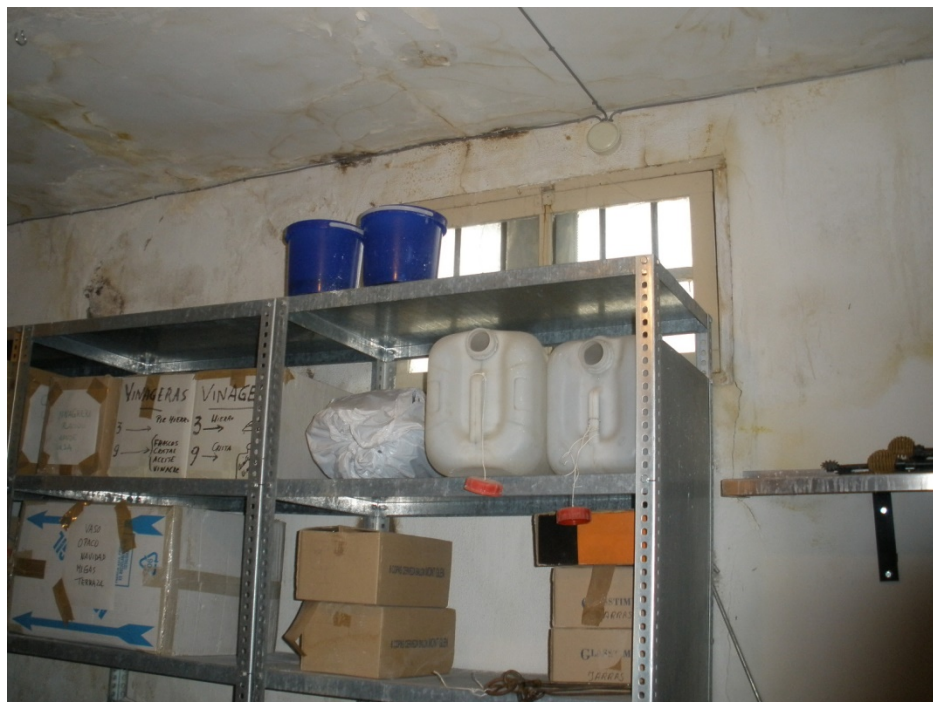
Detalle muro de cerramiento con el patio interior. Se muestran las grandes humedades en paramento y techo
