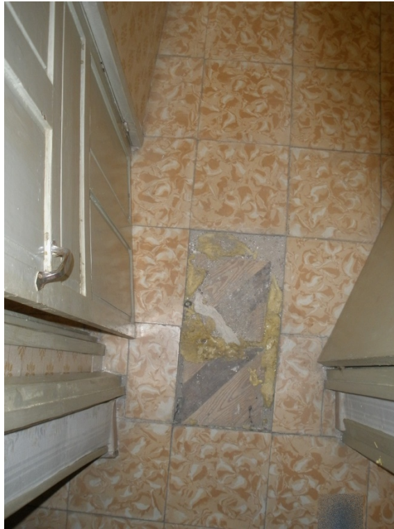
Interior de planta primera de vivienda de Calle Aljibillos, 3. Se observan varias capas de solado superpuestos
