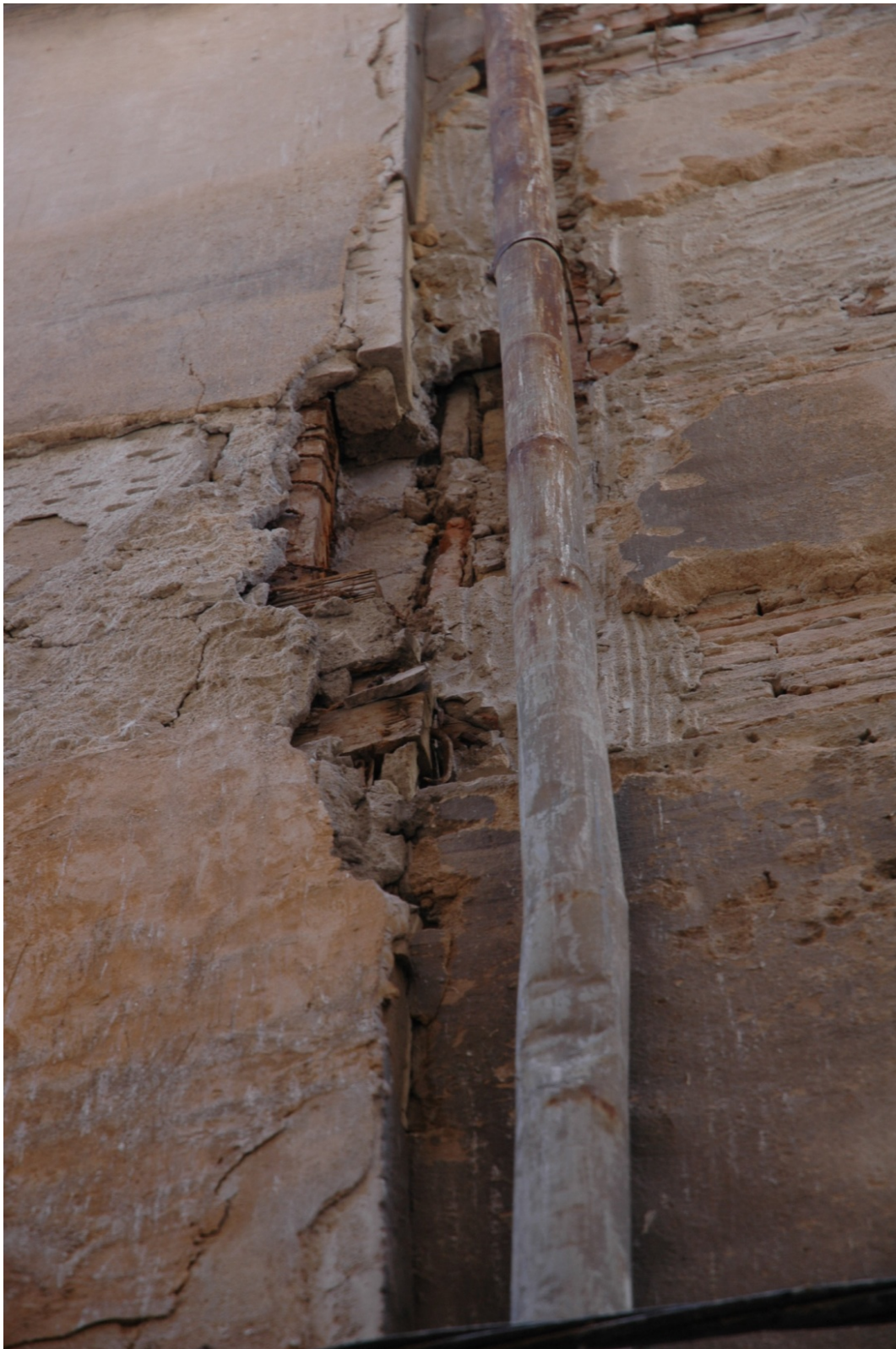
Detalle de los desprendimientos de la fachada a la travesía de Aljibillos.
