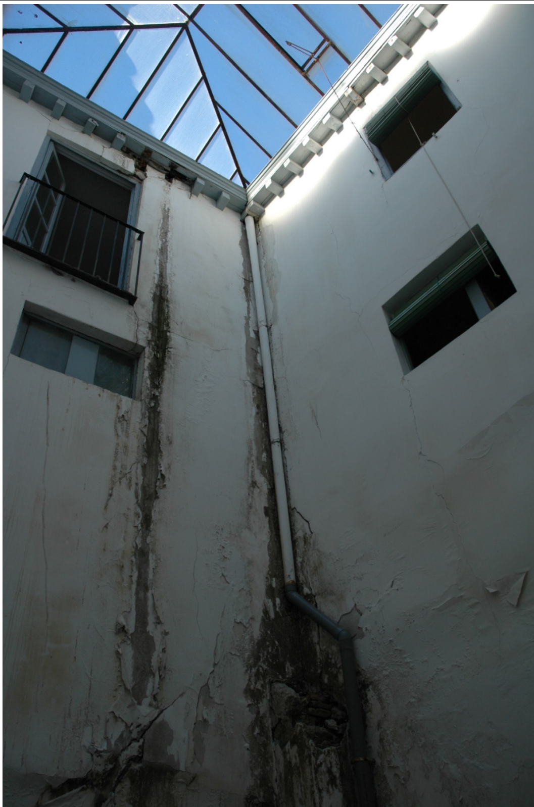
Fachada interior del patio. Se muestran las grietas y los daños producidos por las filtraciones desde el tejado.
