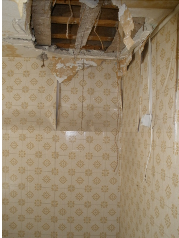
Interior de la planta primera de la vivienda de Calle Aljibillos, 3. Se observan abombamientos en los muros. La cata realizada en el forjado muestra que el mismo está en buen estado.
