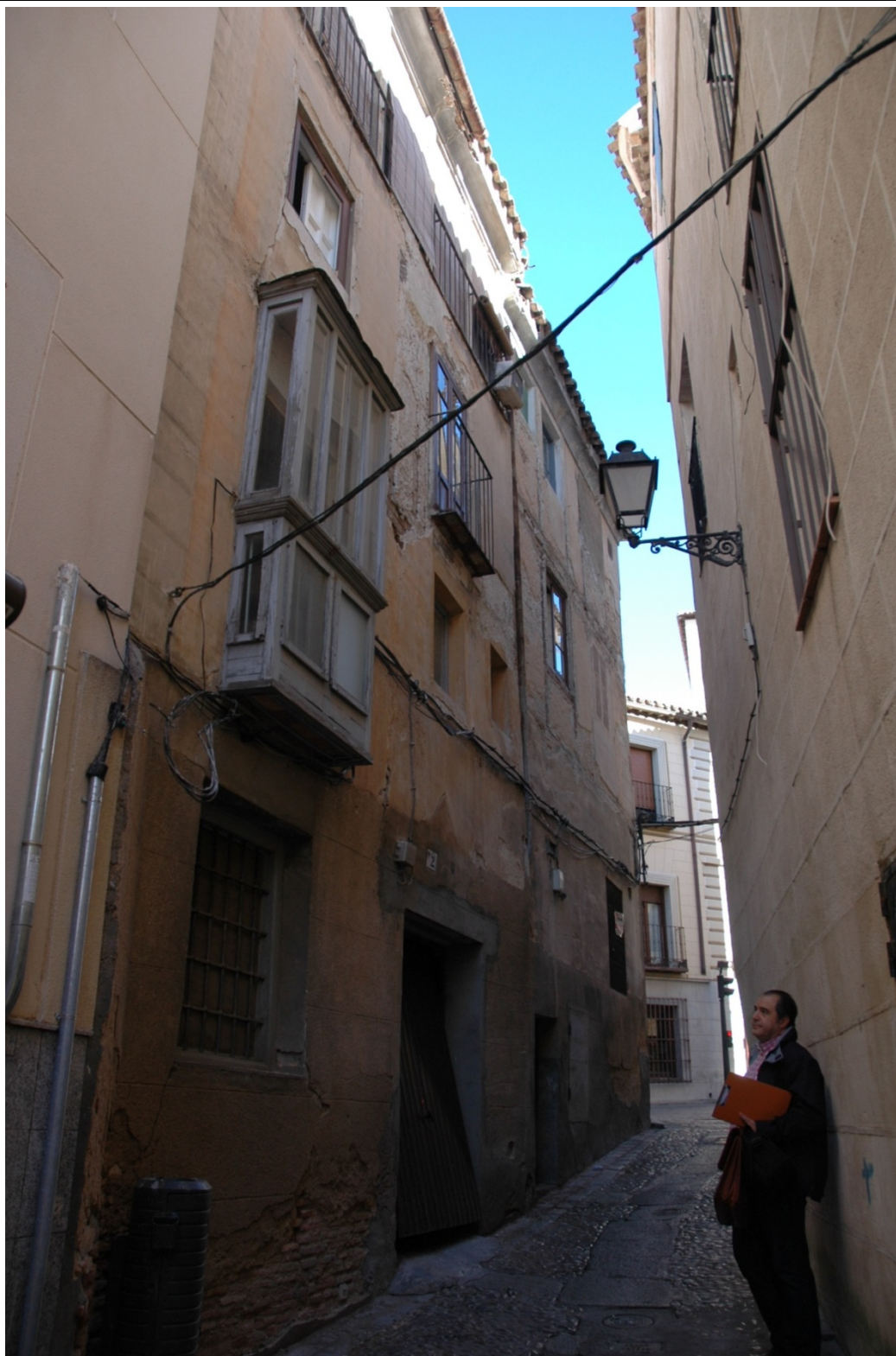
Imagen general de la fachada a la travesía de Aljibillos. Se aprecian las múltiples zonas en las que se han perdido los revocos
