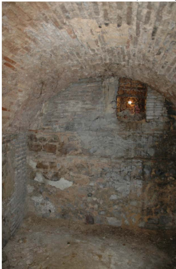
Sótano. Galería Suroeste. Muros de cimentación de fábrica de piedra irregular y bóvedas de ladrillo.
