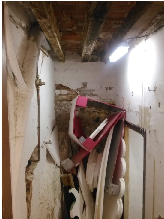
Interior de planta sótano del local de la Calle Aljibillos, 3. Se ven los daños en los muros.
