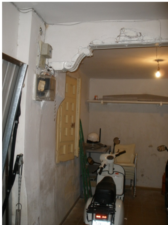
Interior de planta baja del local-almacén de la Travesía Aljibillos, 2. Se muestran zonas de humedades en las partes bajas de los muros.
