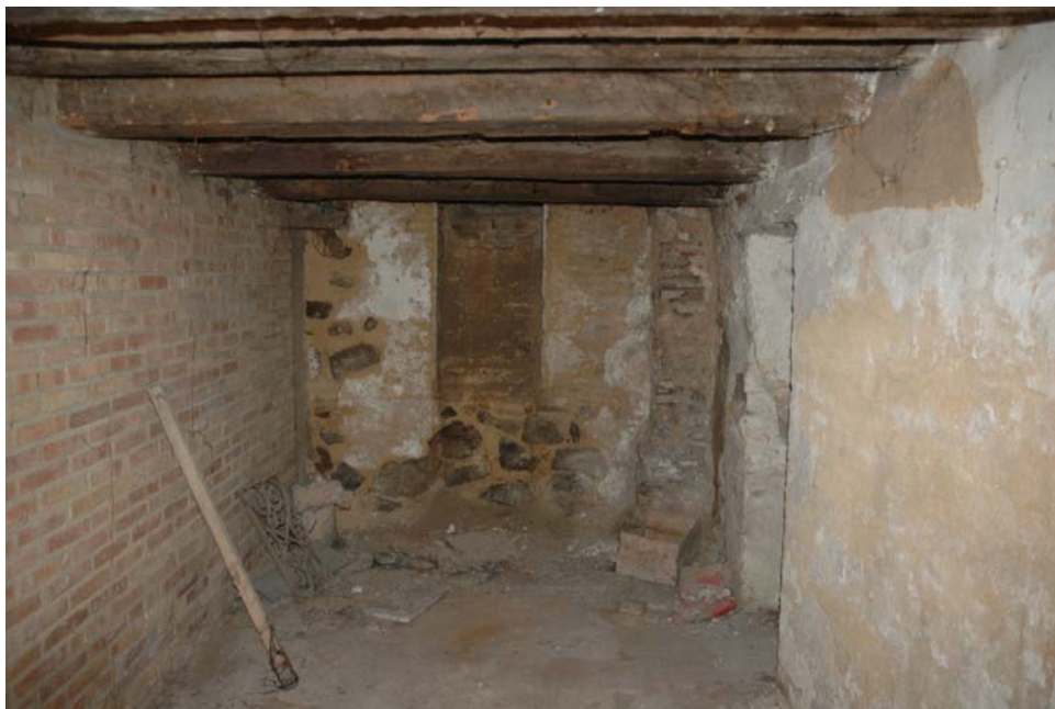
Sótano Galería Suroeste. Muros de cimentación de fábrica de piedra irregular. Tramo techado con forjado de madera.
