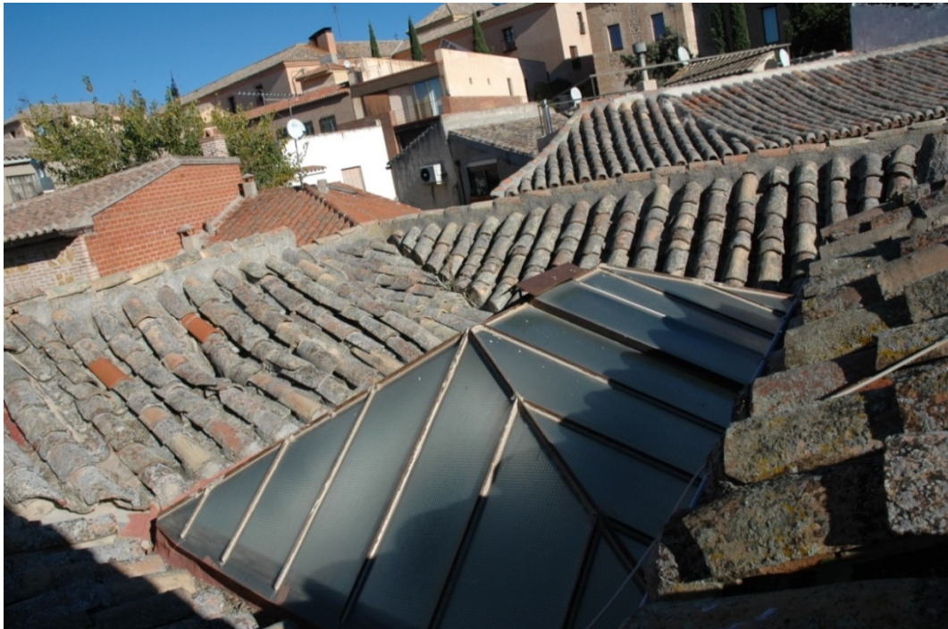
Imagen general de los tejados. Se aprecian las zonas de faldones flechados producto de rotura de la estructura portante
