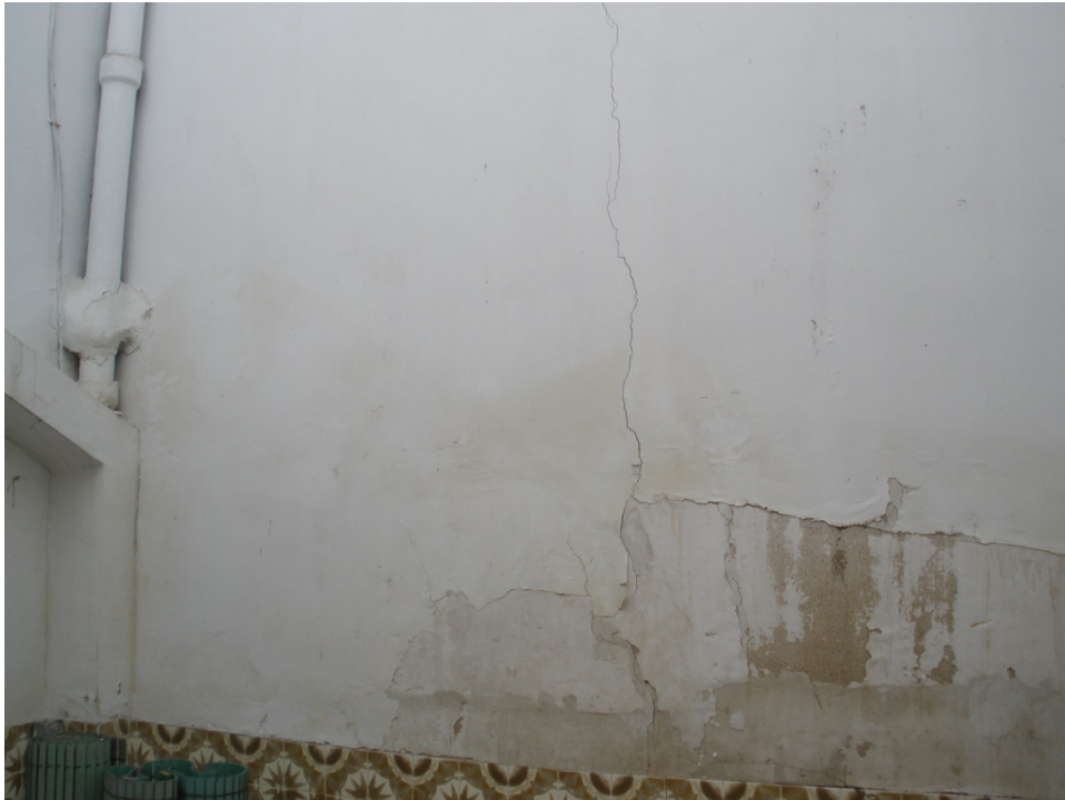
Fachada interior del patio. Se muestran las grietas y las humedades existentes en los muros de carga perimetrales del patio.
