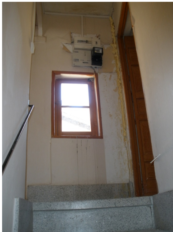
Interior de planta segunda de vivienda de Calle Aljibillos, 3. Se observan la grieta de separación que se mostraba en la fachada entre esta casa y la casa adosada situada en Travesía Aljibillos, 2.
