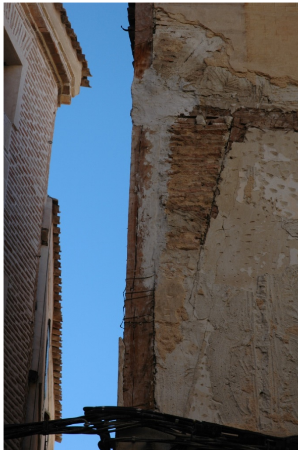
Detalle de los desprendimientos del revoco, dejando la estructura de madera a la intemperie de la fachada Noroeste a la calle Aljibillos.
