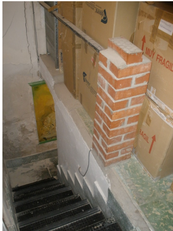
Interior de planta primera del local-almacén de la Travesía Aljibillos, 2. Se muestran en el muro de la escalera varias fisuras de importancia.
