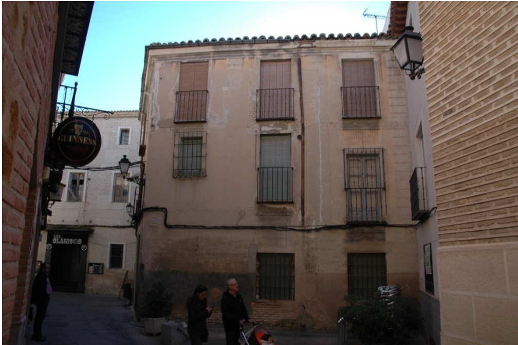
Imagen general de la fachada Noroeste a la calle Aljibillos.
