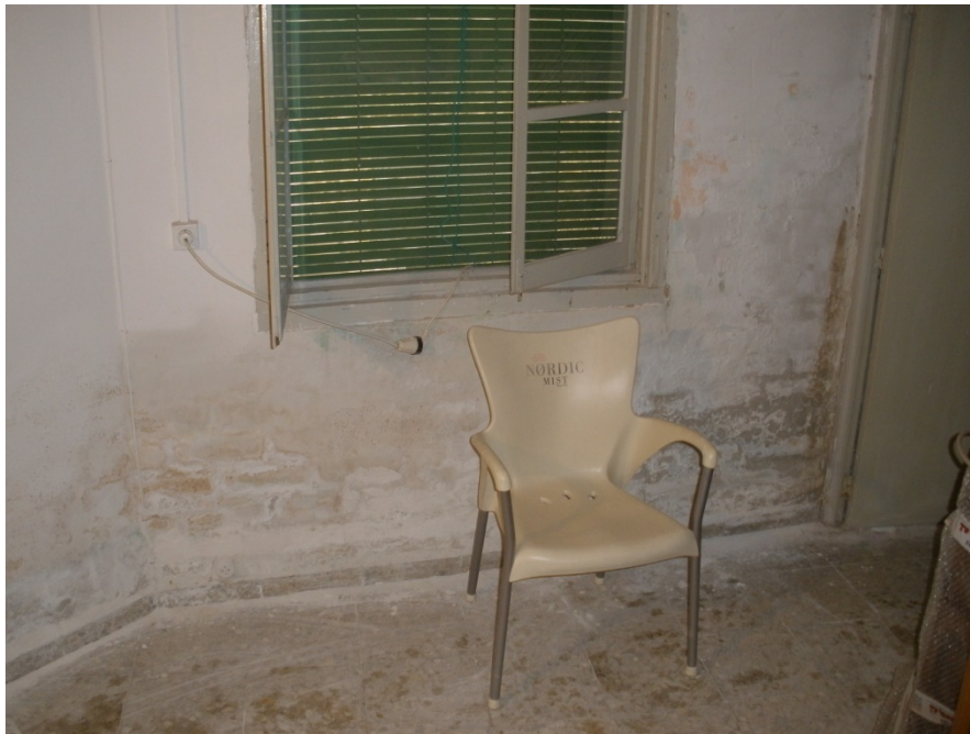
Interior de la planta baja de la vivienda de Calle Aljibillos, 3. Se observan las grandes zonas de humedades en los bajos de los muros.
