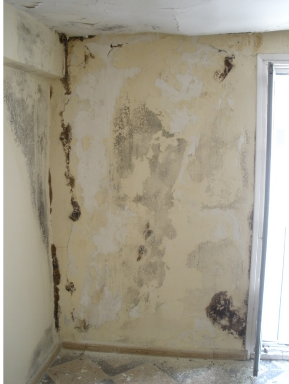
Interior de planta segunda de vivienda de Calle Aljibillos, 3. Se observan grandes zonas de humedades en paramentos.
