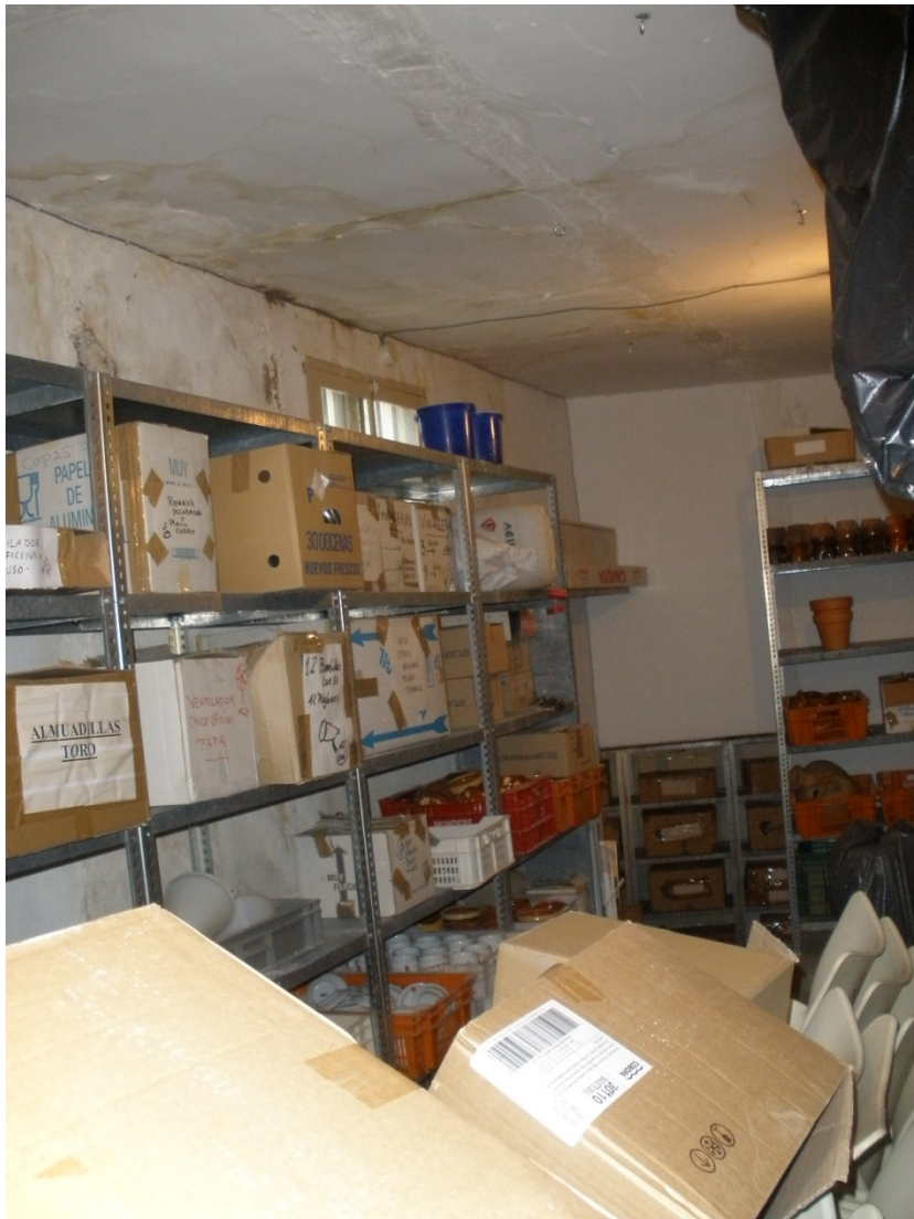
Detalle del techo del nivel superior de la planta primera del local-almacén, mostrando las humedades en paramento exterior y techo.
